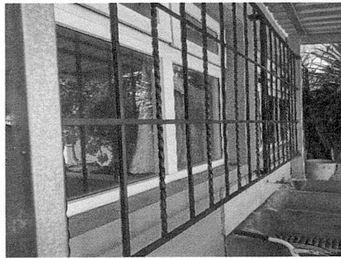
Mantenimiento a barandas de metal en pasillos (barandas, pasamanos y balcones.
