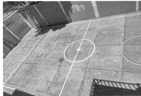
Mantenimiento de piso de cancha deportiva con suministro y aplicación de pintura epoxica colores (limpieza, resane y aplicación)
