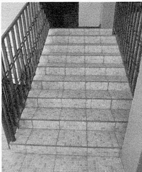
Sustitucion de piso (gradas)
