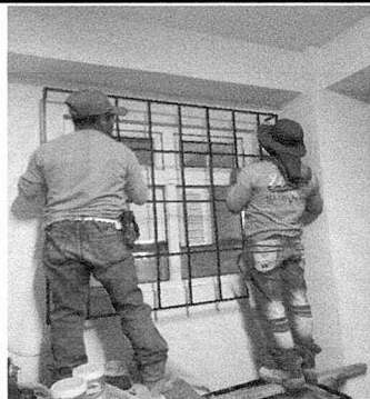
Sustitución de balcones (dirección)
