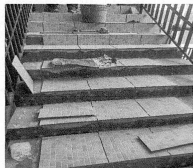
Sustitucion de piso (gradas)
