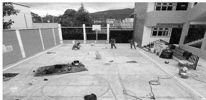
Mantenimiento de piso de cancha deportiva con suministro y aplicación de pintura epoxica colores (limpieza, resane y aplicación)
