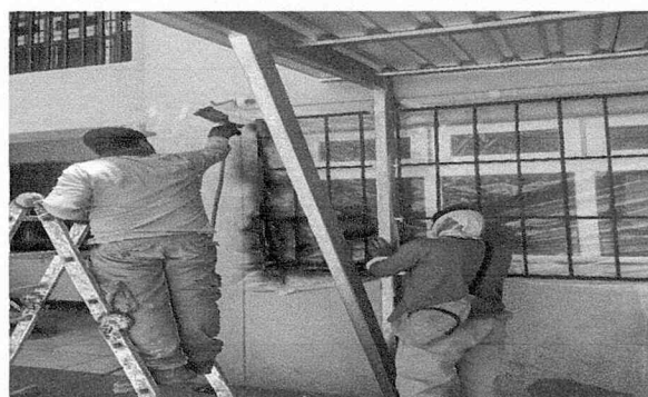
Mantenimiento a barandas de metal en pasillos (Barandas, pasamanos y balcones)
