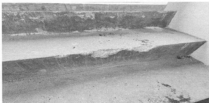
Sustitucion de piso (gradas)
