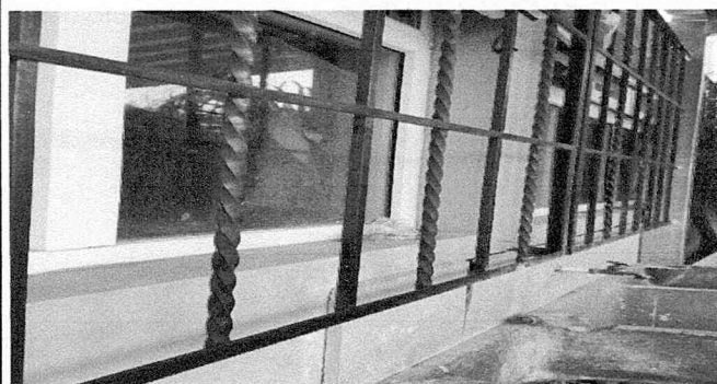
Mantenimiento a barandas de metal en pasillos (Barandas, pasamanos y balcones)
