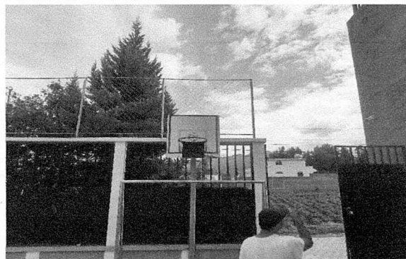
Sustitución de barandas de metal en pasillos o divisiones (perimetral)
