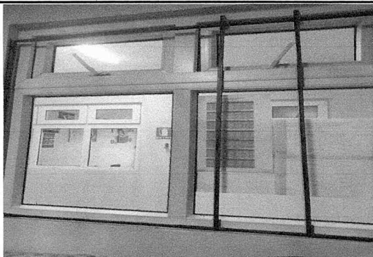
Sustitución de balcones (dirección)
