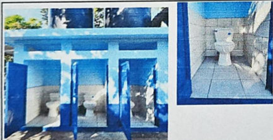
FOTO 5: SUSTITUCIÓN DE AZULEJO
