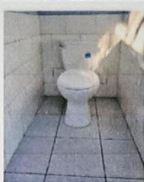
FOTO 7: SUSTITUCIÓN DE PISO DE CONCRETO A PISO ANTIDESLIZANTE
