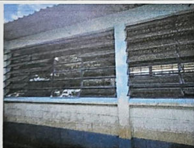
FOTO 11: SUSTITUCIÓN DE VIDRIO DE 5MM
