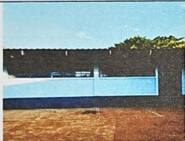
FOTO 3: APLICACIÓN DE PINTURA INTERIOR LATEX (LIMPIEZA, RESANE Y APLICACIÓN)
