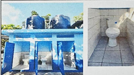
FOTO 4: SUSTITUCIÓN DE INODORO ELONGADO
