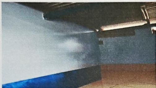
FOTO 1: SUSTITUCIÓN DE PISO DE CONCRETO A CERÁMICO
