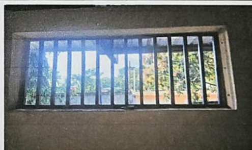
FOTO 12: SUSTITUCIÓN DE BALCÓN
