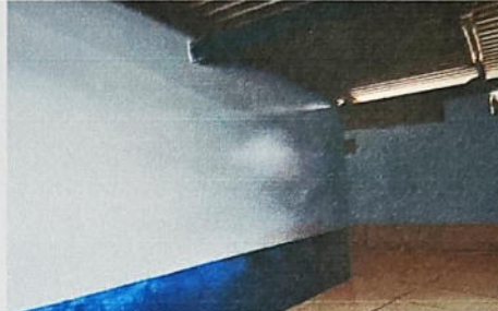
FOTO 2: SUSTITUCIÓN DE MURO DE MADERA A MURO PREFABRICADO DE TABLAYESO
