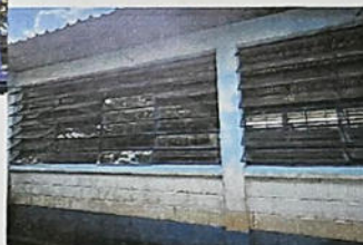
FOTO 10: MANTENIMIENTO DE ESTRUCTURA METÁLICA DE VENTANAS
