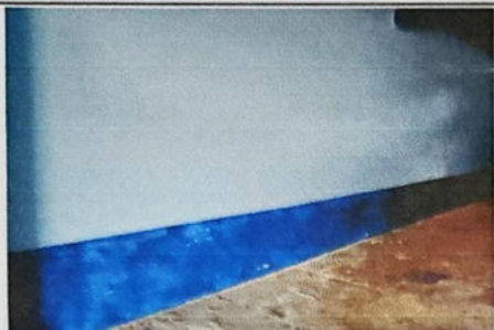
FOTO 1: SUSTITUCIÓN DE PISO DE CONCRETO A CERÁMICO
