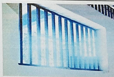
FOTO 12: SUSTITUCIÓN DE BALCÓN
