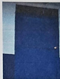
FOTO 8: SUSTITUCIÓN DE PUERTA METÁLICA
