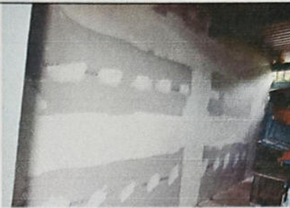
FOTO 2: SUSTITUCIÓN DE MURO DE MADERA A MURO PREFABRICADO DE TABLAYESO
