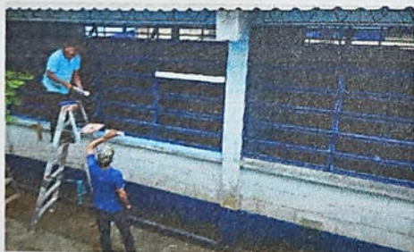
FOTO 11: SUSTITUCIÓN DE VIDRIO DE 5MM
