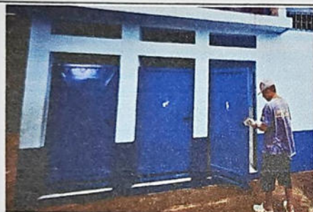
FOTO 9: MANTENIMIENTO Y REPARACIÓN DE PUERTAS METÁLICAS
