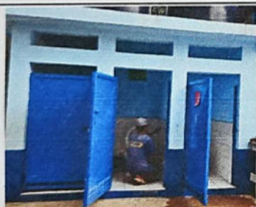
FOTO 5: SUSTITUCIÓN DE AZULEJO
