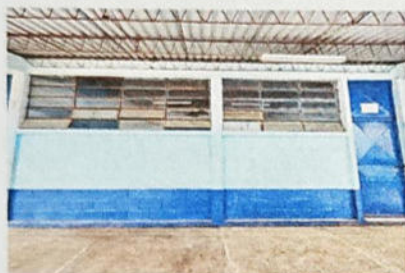
FOTO 3: APLICACIÓN DE PINTURA INTERIOR LATEX (LIMPIEZA, RESANE Y APLICACIÓN)
