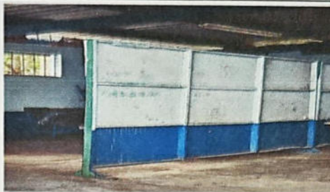
FOTO 2: SUSTITUCIÓN DE MURO DE MADERA A MURO PREFABRICADO DE TABLAYESO
