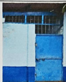
FOTO 8: SUSTITUCIÓN DE PUERTA METÁLICA
