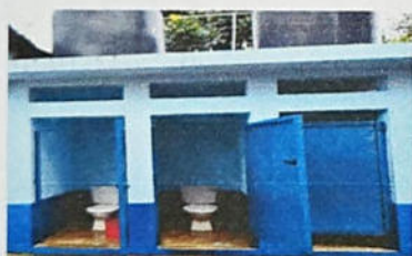
FOTO 5: SUSTITUCIÓN DE AZULEJO
