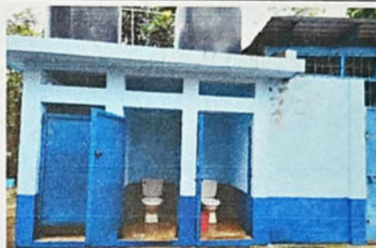
FOTO 4: SUSTITUCIÓN DE INODORO ELONGADO
