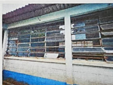
FOTO 10: MANTENIMIENTO DE ESTRUCTURA METÁLICA DE VENTANAS
