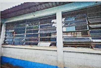
FOTO 11: SUSTITUCIÓN DE VIDRIO DE 5MM
