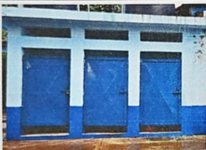
FOTO 9: MANTENIMIENTO Y REPARACIÓN DE PUERTAS METÁLICAS
