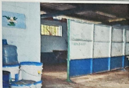
FOTO 1: SUSTITUCIÓN DE PISO DE CONCRETO A CERÁMICO
