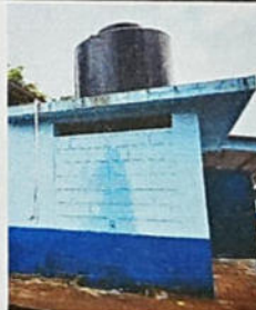
FOTO 6: SUSTITUCIÓN DE ACCESORIOS PARA DEPÓSITO DE AGUA Y REPARACIÓN DE SISTEMA DE AGUA
