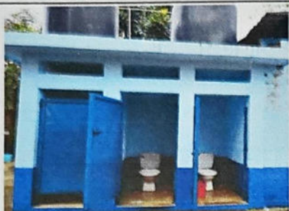
FOTO 7: SUSTITUCIÓN DE PISO DE CONCRETO A PISO ANTIDESLIZANTE
