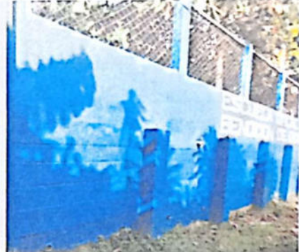
MANTENIMIENTO PREVENTIVO DE MUROS EXTERIORES APLICACIÓN DE PINTURA DE 199 M2
