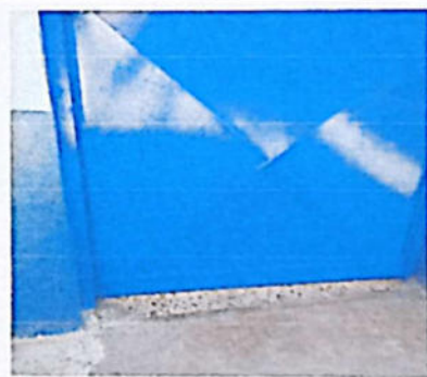
MANTENIMIENTO A ESTRUCTURA DE PUERTAS (LIJADO, CEPILLADO Y APLICACIÓN DE PINTURA) 28 M2
