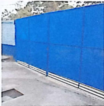
MANTENIMIENTO A PORTON DE METAL PRINCIPAL (LIJADO, PINTADO Y CAMBIO DE PERFIL DAÑADO) UNA UNIDAD
