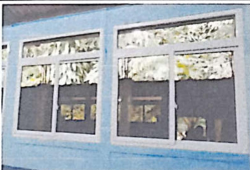
SUSTITUCION DE VENTANA DE METAL, POR VENTANA PVC CON VIDRIOS DE 5MM DE 47 M2
