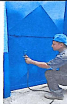
MANTENIMIENTO A ESTRUCTURA DE PUERTAS (LIJADO, CEPILLADO Y APLICACIÓN DE PINTURA) 28 M2
