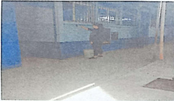
MANTENIMIENTO PREVENTIVO DE MUROS INTERIORES APLICACIÓN DE PINTURA DE 246.25 M2
