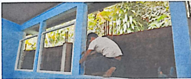
SUSTITUCION DE VENTANA DE METAL, POR VENTANA PVC CON VIDRIOS DE 5MM DE 47 M2
