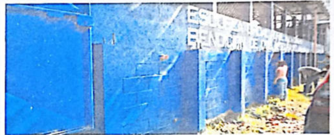
MANTENIMIENTO PREVENTIVO DE MUROS EXTERIORES APLICACIÓN DE PINTURA DE 199 M2
