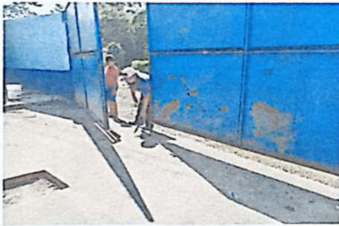
MANTENIMIENTO A PORTON DE METAL PRINCIPAL (LIJADO, PINTADO Y CAMBIO DE PERFIL DAÑADO) UNA UNIDAD
