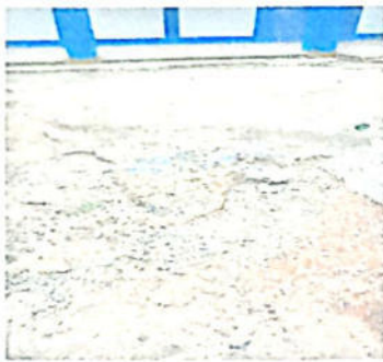
REPARACIÓN DE PLANCHA DE CONCRETO DE PATIO
