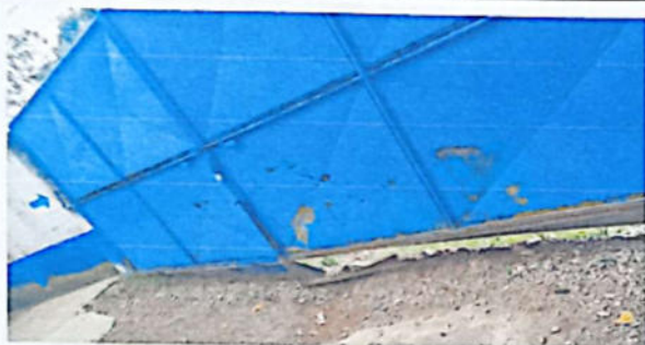
MANTENIMIENTO A PORTON DE METAL PRINCIPAL (LIJADO, PINTADO Y CAMBIO DE PERFIL DAÑADO)
