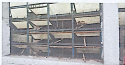
SUSTITUCION DE VENTANA DE METAL, POR VENTANA PVC CON VIDRIOS DE 5MM
