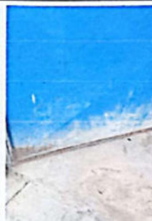
MANTENIMIENTO A ESTRUCTURA DE PUERTAS (LIJADO, CEPILLADO Y APLICACIÓN DE PINTURA.)
