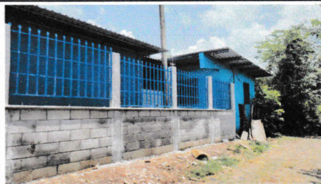
Foto # 2: FABRICACIÓN E INSTALACIÓN DE BARANDAL
