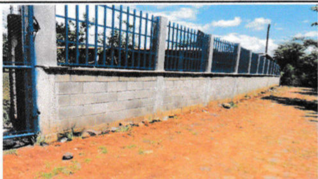
Foto # 3: REPARACIÓN DE MURO PERIMETRAL DE BLOCK Y HIERRO
