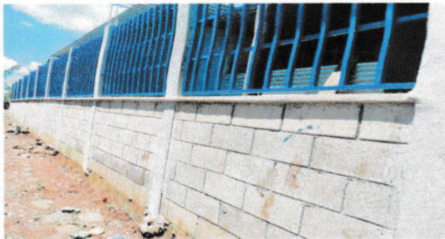
Foto # 1: REPARACIÓN DE MURO PERIMETRAL DE BLOCK Y HIERRO
