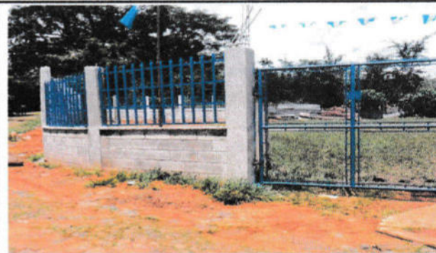
Foto # 4: FABRICACIÓN E INSTALACIÓN DE BARANDAL
