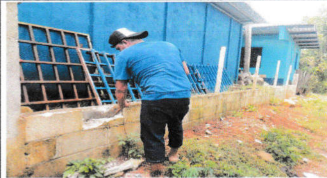
Foto # 2: FABRICACIÓN E INSTALACIÓN DE BARANDAL
