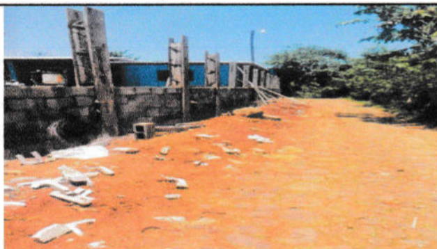
Foto # 3: REPARACIÓN DE MURO PERIMETRAL DE BLOCK Y HIERRO
