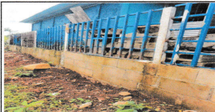
Foto 1: Reparación de muro perimetral existente de block
