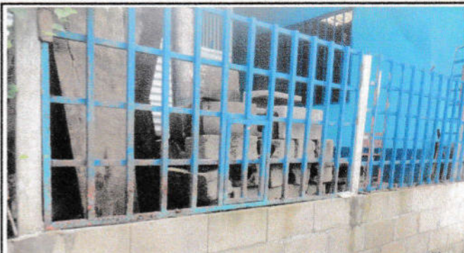
Foto 2: Sustitución de reja perimetral
