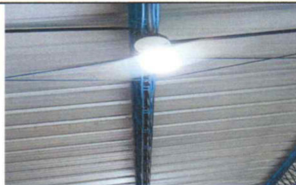
FOTO 4. REPARACION CABLEADO ELECTRICO CAL.12AWG COCINA
