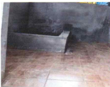
FOTO 3. SUSTITUCION DE PISO DE CONCRETO POR CERÁMICO
