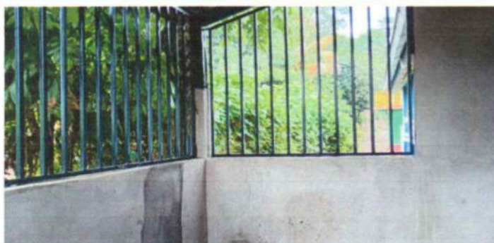
FOTO 5. SUSTITUCION DE BALCONES DE LAMINA POR METAL
