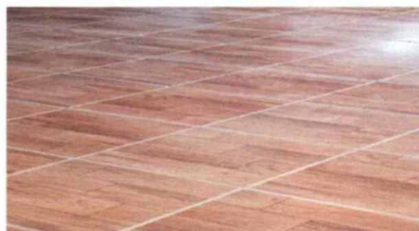
FOTO 10. SUSTITUCIÓN DE PISO DE CONCRETO, POR PISO CERAMICO AULAS
