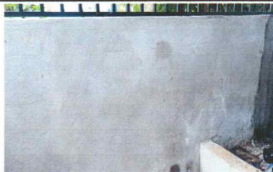
FOTO 8. REPELLO GRIS EN MURO
