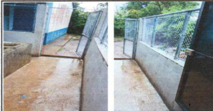
FOTO 2. REPARACION DE MURO CON BLOCK DE 50KG/CM2 14X19X39 + MALLA GALVANIZADA
