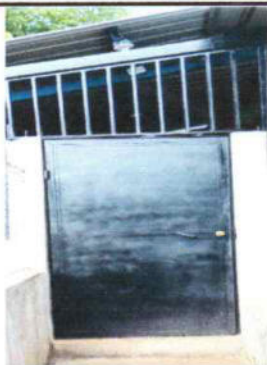
FOTO 1. SUSTITUCION DE PUERTA METÁLICA
