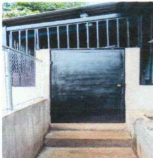
FOTO 7. REPARACION DE MURO CON BLOCK DE 50KG/CM2 14X19X39 COCINA
