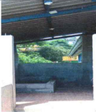
FOTO 1. SUSTITUCION DE PUERTA METÁLICA
