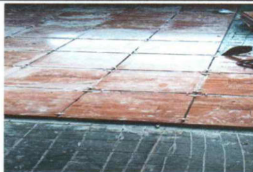
FOTO 10. SUSTITUCIÓN DE PISO DE CONCRETO, POR PISO CERAMICO AULAS
