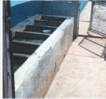
FOTO 2. REPARACION DE MURO CON BLOCK DE 50KG/CM2 14X19X39 + MALLA GALVANIZADA
