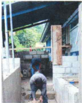
FOTO 7. REPARACION DE MURO CON BLOCK DE 50KG/CM2 14X19X39 COCINA
