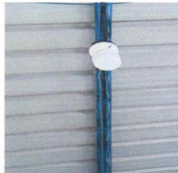
FOTO 4. REPARACION CABLEADO ELECTRICO CAL.12AWG COCINA
