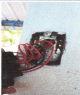
FOTO 9. REPARACION CABLEADO ELECTRICO CAL.12AWG AULAS
