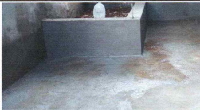
FOTO 3. SUSTITUCION DE PISO DE CONCRETO POR CERÁMICO
