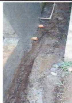
FOTO 6. SUSTITUCION DE TUBERÍA PVC AGUAS NEGRAS
