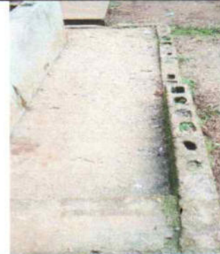
FOTO 2. REPARACION DE MURO CON BLOCK DE 50KG/CM2 14X19X39 + MALLA GALVANIZADA
