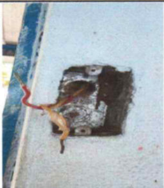
FOTO 9. REPARACION CABLEADO ELECTRICO CAL. 12AWG AULAS
