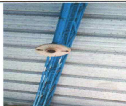
FOTO 4. REPARACIÓN CABLEADO ELÉCTRICO CAL. 12AWG COCINA
