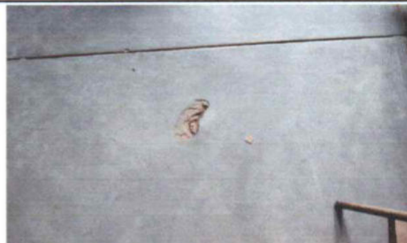
FOTO 10. SUSTITUCIÓN DE PISO DE CONCRETO, POR PISO CERAMICO AULAS
