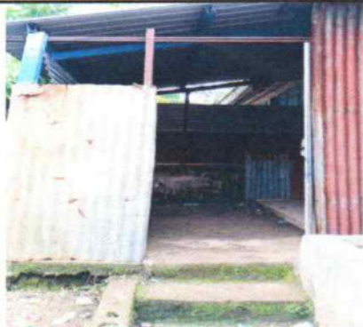
FOTO 7. REPARACION DE MURO CON BLOCK DE 50KG/CM2 14X19X39 COCINA
