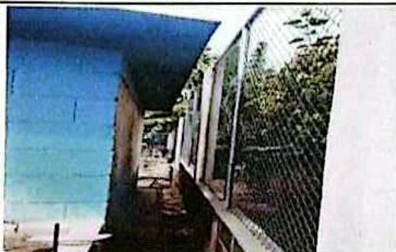
Sustitución de muro perimetral de mampostería de block con columnas de 0.20x0.14 a cada 6.00 metros (Incluye cimientado de 0.30x0.15m)
