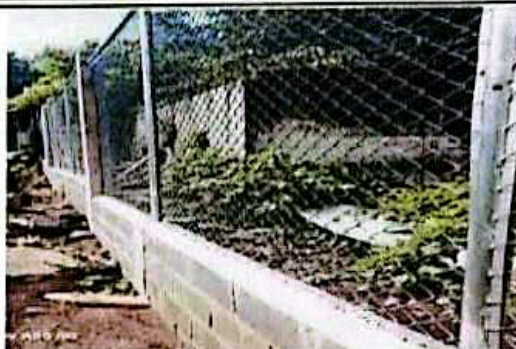
Foto 2: Sustitución de muro perimetral de mampostería de block con columnas de 0.20x0.14 a cada 6.00 metros (incluye cimientado de 0.30x0.15m). Se sustituyó un total de 90 metros cuadrados.
