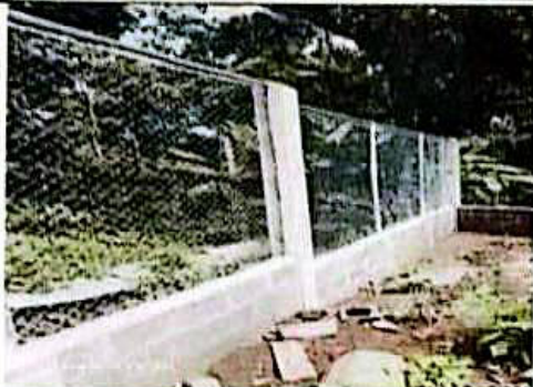
Foto 1: Sustitución de cerco perimetral de tubo y malla galvanizada (Altura 2.00m). Se sustituyó un total de 65 metros cuadrados.
