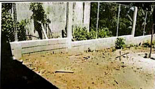
Sustitución de cerco perimetral de tubo y malla galvanizada (Altura 2.00m).
