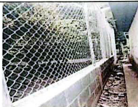
Sustitución de muro perimetral de mampostería de block con columnas de 0.20x0.14 a cada 6.00 metros (Incluye cimientado de 0.30x0.15m)
