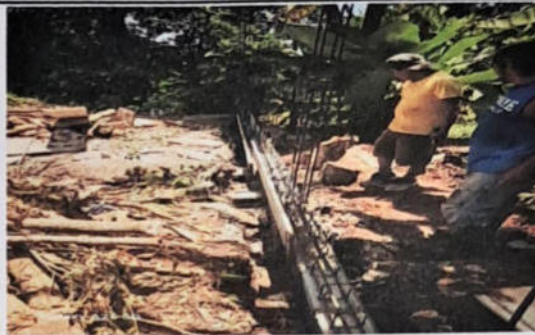
Foto 2: Sustrucción de muro perimetral de mampostería de block con columnas de 0.20x0.14 a cada 6.00 metros (incluye cimiento de 0.30x0.15m). Se sustituyó un total de 90 metros cuadrados.
