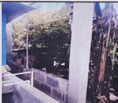
Sustrucción de muro perimetral de mampostería de block con columnas de 0.20x0.14 a cada 6.00 metros (incluye cimiento de 0.30x0.15m)
