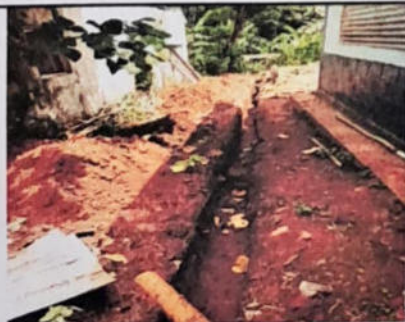
Sustrucción de cerco perimetral de tubo y malla galvanizada (Altura 2.00m).
