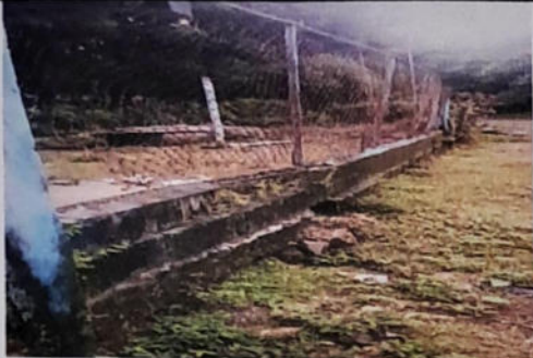
Foto 1: Sustrucción de cerco perimetral de tubo y malla galvanizada (Altura 2.00m),
