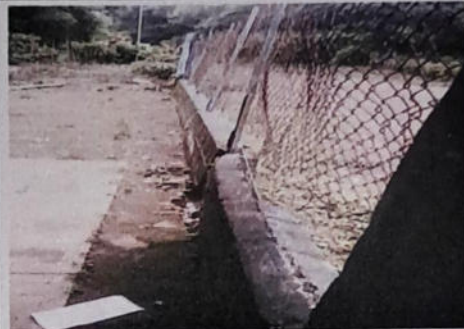
Foto 2: Sustrucción de muro perimetral de mampostería de block con columnas de 0.20x0.14 a cada 6.00 metros (incluye cimbrío de 0.30x0.15m)
