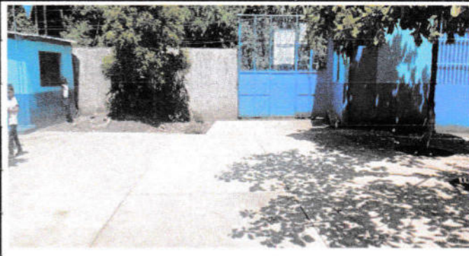
FOTO 2. SUSTITUCIÓN DE PLANCHAS DE CONCRETO EN PATIO (ESPESOR=0.10M)
