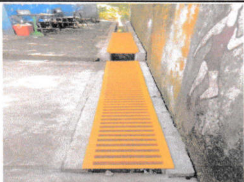
FOTO 3. SUSTITUCION DE REJILLAS DE METAL
