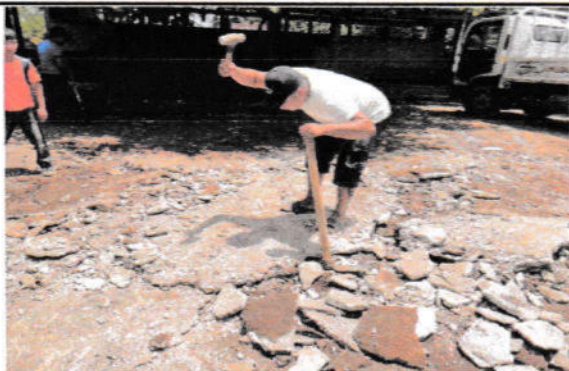
FOTO 1. SUSTITUCIÓN DE PLANCHAS DE CONCRETO EN PATIO (ESPESOR=0.10M)
