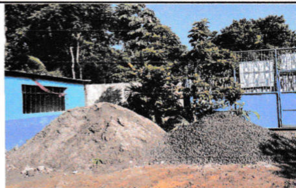
FOTO 2. SUSTITUCIÓN DE PLANCHAS DE CONCRETO EN PATIO (ESPESOR=0.10M)
