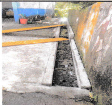
FOTO 3. SUSTITUCION DE REJILLAS DE METAL
