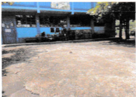
SUSTITUCIÓN DE PLANCHAS DE CONCRETO EN PATIO (ESPESOR=0.10M)
