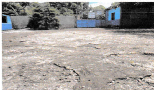
SUSTITUCIÓN DE PLANCHAS DE CONCRETO EN PATIO (ESPESOR=0.10M)
