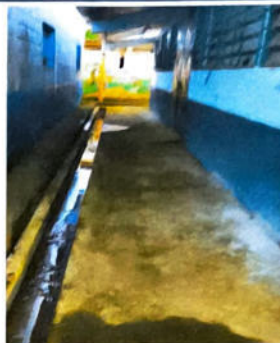
Foto #2 Reparación de manejo de agua Pluvial con canal U
