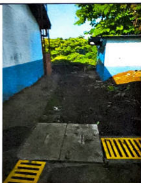
Foto #3 Sustitución de tubería pvc línea principal de 6 pulgadas para agua pluvial
