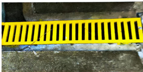
Foto #4 Sustitución de canal U para manejo de aguas pluviales
