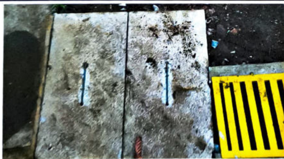
Foto #5 Reparación de drenaje Pluvial con caja de registro/unión
