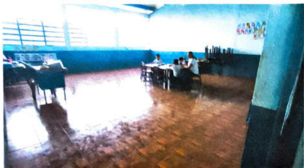
Foto #1 Sustitución de piso de concreto por piso ceramico
