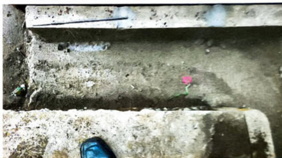
Foto #4 Sustitución de canal U para manejo de aguas pluviales
