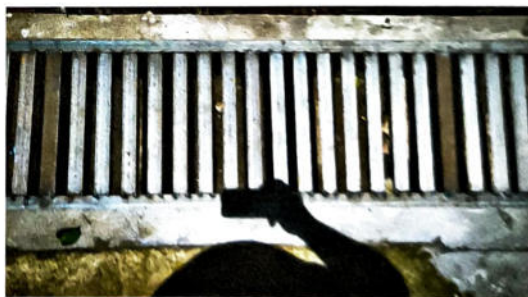
Foto #6 Sustitución de rejilla de metal en canal para manejo de aguas pluviales
