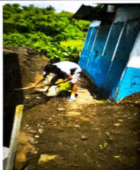
Foto #3 Sustitución de tubería pvc línea principal de 6 pulgadas para agua pluvial
