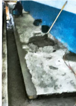
Foto #2 Reparación de manejo de agua Pluvial con canal U
