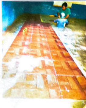
Foto #1 Sustitución de piso de concreto por piso ceramico
