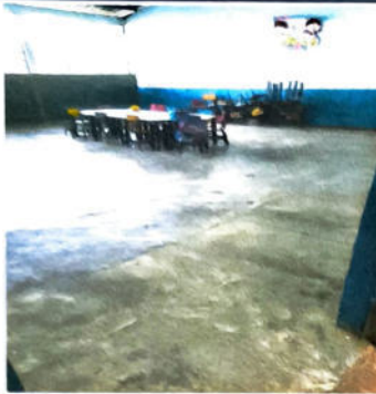
Foto #1 Sustitución de piso de concreto por piso ceramico
