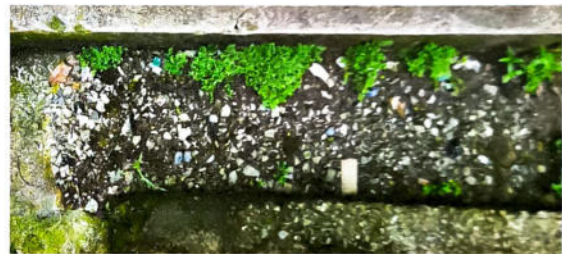
Foto #4 Sustitución de canal U para manejo de aguas pluviales
