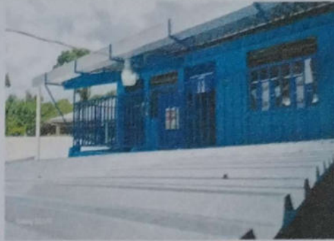
Foto 2: SUSTITUCIÓN DE COBERTURA DE TECHO DE LAMINA
