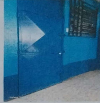
Foto 8: MANTENIMIENTO A ESTRUCTURA DE PUERTA, LIJADO, CEPILLADO Y APLICACIÓN DE PINTURA
