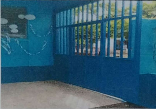
Foto 7: SUSTITUCIÓN DE PORTÓN METÁLICO
