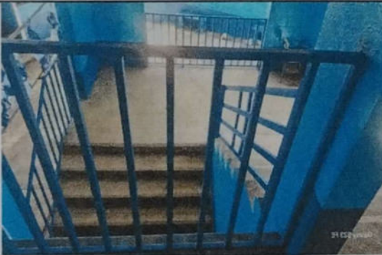
Foto 9: SUSTITUCIÓN DE BARANDA DE METAL
