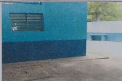
Foto 6: APLICACIÓN DE PINTURA LATEX AZUL PARA ZOCALO
