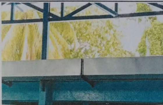
Foto 3: SUSTITUCIÓN DE CANAL DE METAL
