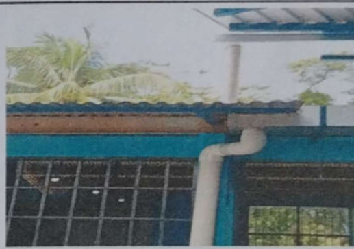
Foto 4: SUSTITUCIÓN DE BAJADA DE AGUA PLUVIAL DE TUBO PVC
