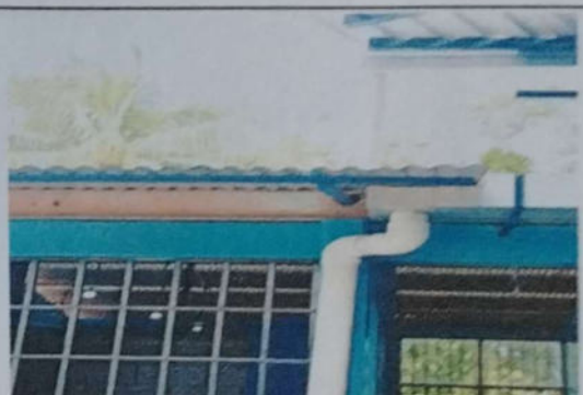
Foto 4: SUSTITUCIÓN DE BAJADA DE AGUA PLUVIAL DE TUBO PVC
