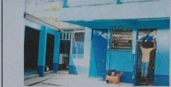
Foto 8: MANTENIMIENTO A ESTRUCTURA DE PUERTA, LIJADO, CEPILLADO Y APLICACIÓN DE PINTURA
