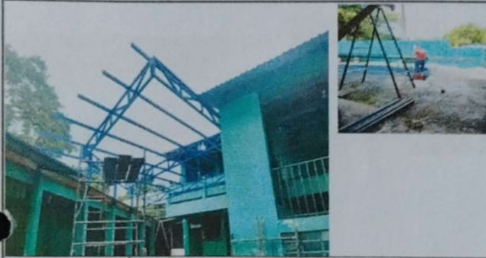
Foto 1: SUSTITUCIÓN DE ESTRUCTURA DE SOPORTE DE METAL POR METAL
