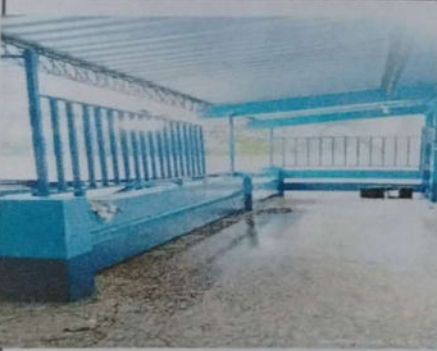
Foto 9: SUSTITUCIÓN DE BARANDA DE METAL
