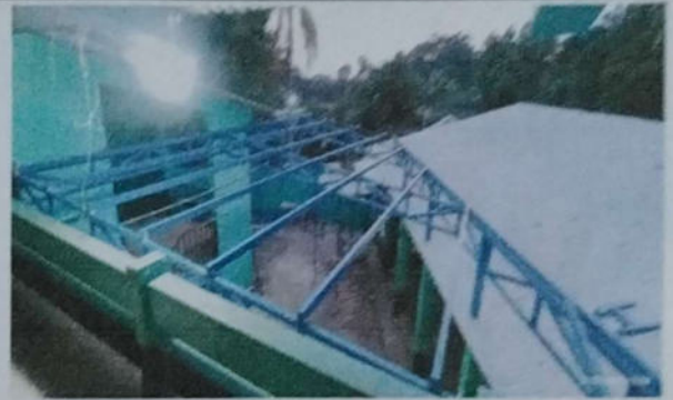
Foto 2: SUSTITUCIÓN DE COBERTURA DE TECHO DE LAMINA
