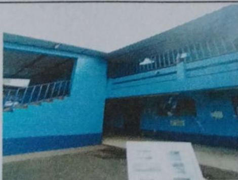
Foto 5: APLICACIÓN DE PINTURA LATEX AZUL CIELO PARA EXTERIORES
