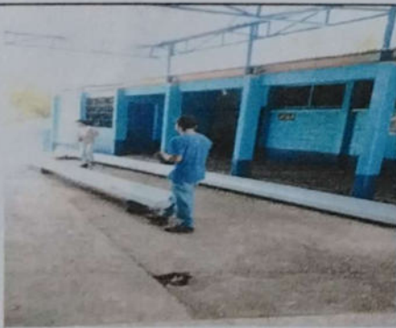
Foto 3: SUSTITUCIÓN DE CANAL DE METAL
