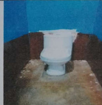
Foto 10: SUSTITUCIÓN DE SANITARIO
