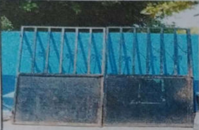
Foto 7: SUSTITUCIÓN DE PORTÓN METÁLICO
