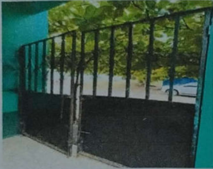
Foto 7: SUSTITUCIÓN DE PORTÓN METÁLICO
