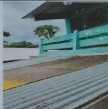
Foto 2: SUSTITUCIÓN DE COBERTURA DE TECHO DE LAMINA
