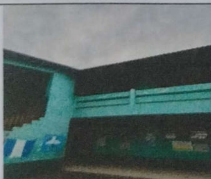
Foto 5: APLICACIÓN DE PINTURA LATEX AZUL CIELO PARA EXTERIORES
