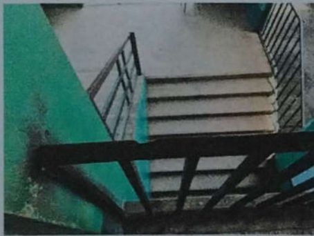
Foto 9: SUSTITUCIÓN DE BARANDA DE METAL
