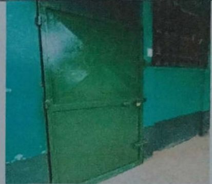
Foto 8: MANTENIMIENTO A ESTRUCTURA DE PUERTA, LIJADO, CEPILLADO Y APLICACIÓN DE PINTURA
