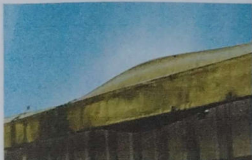
Foto 3: SUSTITUCIÓN DE CANAL DE METAL
