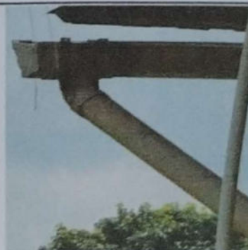
Foto 4: SUSTITUCIÓN DE BAJADA DE AGUA PLUVIAL DE TUBO PVC
