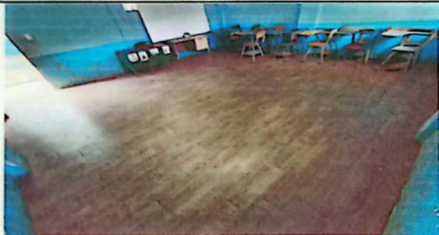
No.1 Sustitución de piso por cerámico 41 m2
