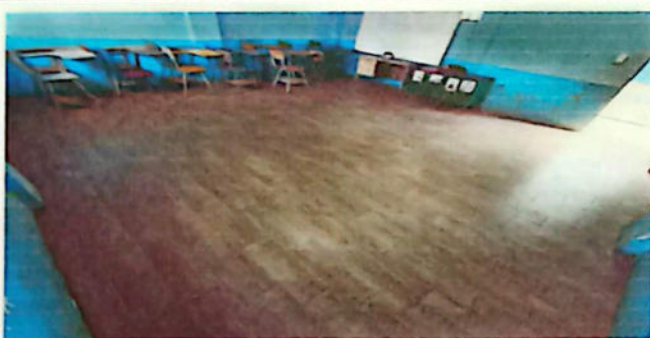
No.3 Sustitución de piso por cerámico 41 m2
