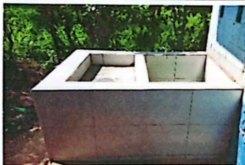
No.7 Reparación de pila de concreto de una ala
