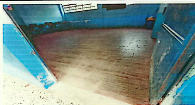
No.2 Sustitución de piso por cerámico 41 m2
