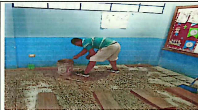
No.2 Sustitución de piso por cerámico 41 m2
