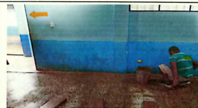
No.6 Sustitución de piso por cerámico 46 m2
