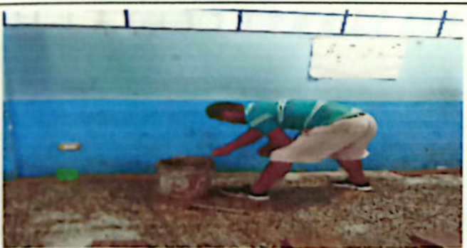
No.5 Sustitución de piso por cerámico 41 m2
