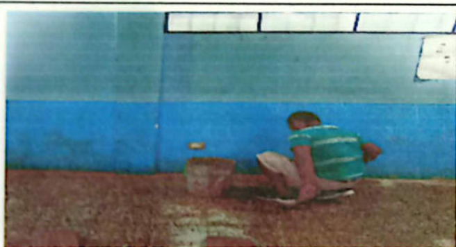
No.3 Sustitución de piso por cerámico 41 m2
