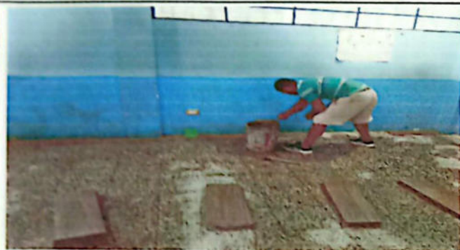
No.1 Sustitución de piso por cerámico 41 m2
