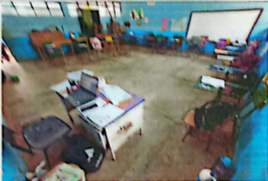
No.1 Sustitución de piso por cerámico.
