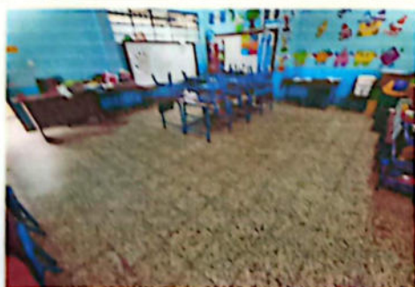
No.5 Sustitución de piso por cerámico
