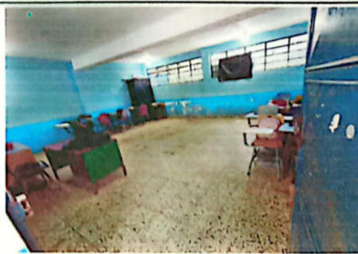
No.2 Sustitución de piso por cerámico
