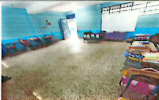
No.3 Sustitución de piso por cerámico
