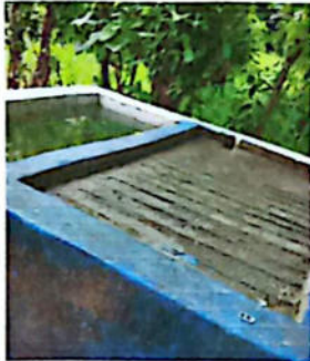
No.7 Reparación de pila de concreto de una ala
