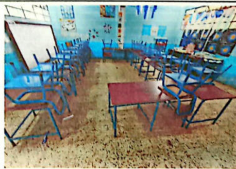
No.4 Sustitución de piso por cerámico
