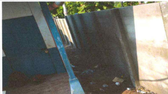
Foto #2 Mantenimiento correctivo de muro perimetral emplatillado de estabilización de suelo con cimentocorrido y muro de block 69 m2
