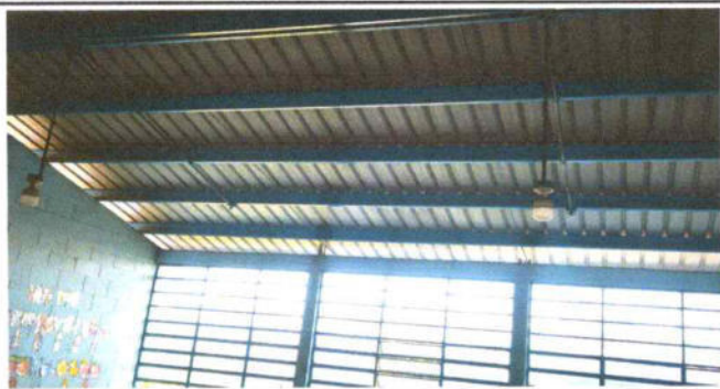
Foto #3 Sustitución de cableado eléctrico Calibre 12 AWG y de bombillos led Globo 30W 2400 lúmenes
