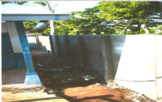
Foto #1 Mantenimiento correctivo de muro perimetral emplatillado de estabilización de suelo con cimentocorrido y muro de block 69 m2
