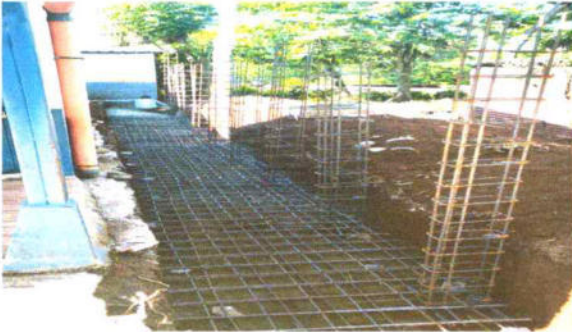
Foto #1 Mantenimiento correctivo de muro perimetral emplattado de estabilización de suelo con cimentocorrido y muro de block TOTAL DE 69 METROS CUADRADOS
