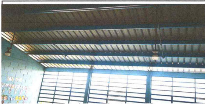
Foto #3 Sustitución de cableado eléctrico Calibre 12 AWG y de bombillos led Globo 30W 2400 lúmenes TOTAL DE 150 METROS LINEALES
