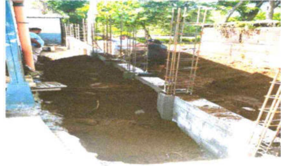
Foto #2 Mantenimiento correctivo de muro perimetral emplattado de estabilización de suelo con cimentocorrido y muro de block TOTAL DE 69 METROS CUADRADOS
