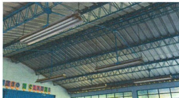
Foto #2 Sustitución de cableado eléctrico Calibre 12 AWG y de bombillos led Globo 30W 2400 lúmenes
