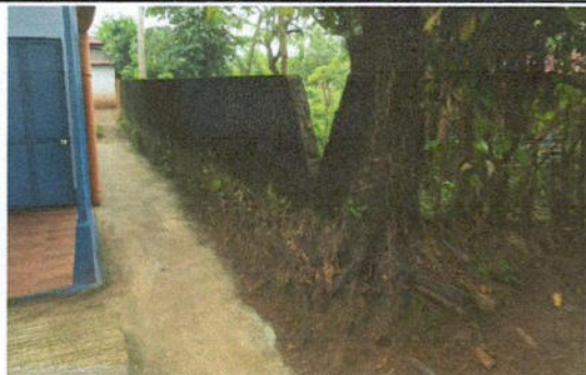
Foto #1 Mantenimiento correctivo de muro perimetral emplastado de estabilización de suelo con cimentocorrido y muro de block
