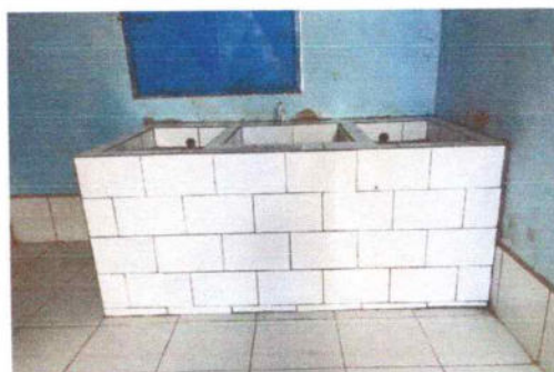
No.6 Sustitución de pila de concreto de 2 alas
