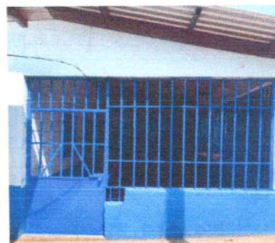
No.4 Mantenimiento y reparación de estructura de puerta (lijado, sujecion, aplicación de pintura)
