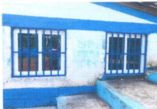
No.2 Suministro y sustitución de ventanas de metal a pvc
