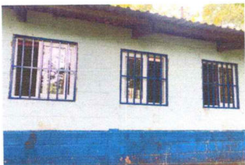
No.3 Sustitución de Balcones de metal
