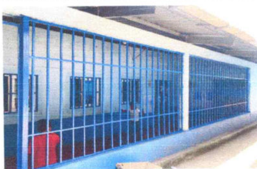
No.5 Mantenimiento de barandas de metal en pasillos (lijado, sujeción y aplicación de pintura)
