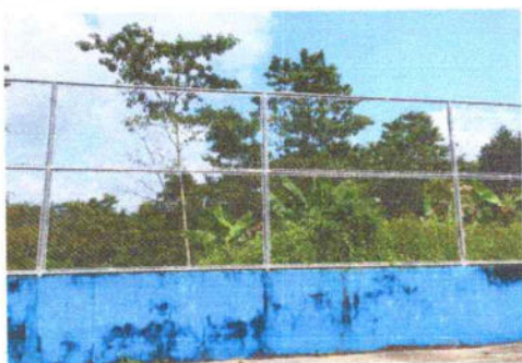
No. 1 Sustitución de cerco perimetral de tubo hg y malla galvanizada (Altura 3.00m) con marcos a 1.50m
