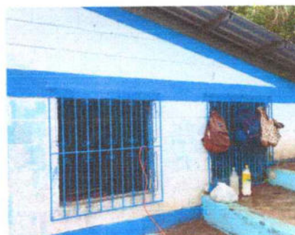
No.2 Suministro y sustitución de ventanas de metal a pvc
