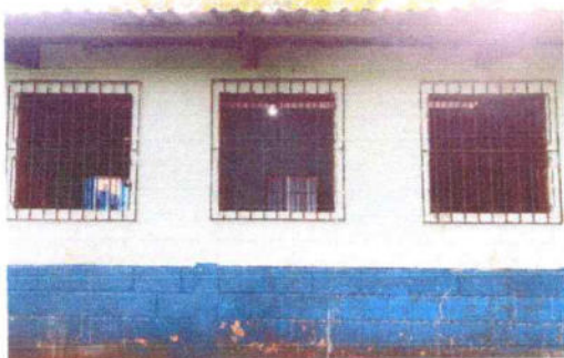
No.3 Sustitución de Balcones de metal
