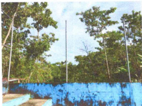
No. 1 Sustitución de cerco perimetral de tubo hg y malla galvanizada (Altura 3.00m) con marcos a 1.50m
