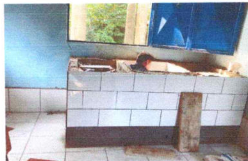
No.6 Sustitución de pila de concreto de 2 alas
