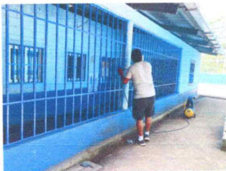
No.5 Mantenimiento de barandas de metal en pasillos (lijado, sujeción y aplicación de pintura)
