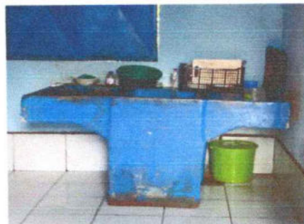
No.6 Sustitución de pila de concreto de 2 alas
