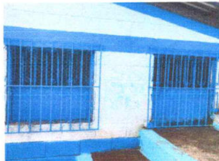
No.2 Suministro y sustitución de ventanas de metal a pvc
