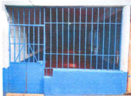
No.4 Mantenimiento y reparación de estructura de puerta (lijado, sujecion, aplicación de pintura)
