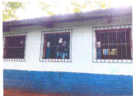
No.3 Sustitución de Balcones de metal
