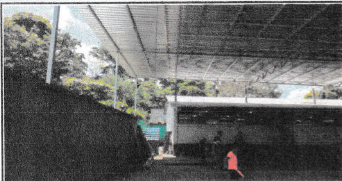
Foto #1: Sustitución de estructura de soporte madera, por metal
