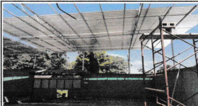
Foto #2: Sustrucción de lámina, por lámina troquelada cal. 26
