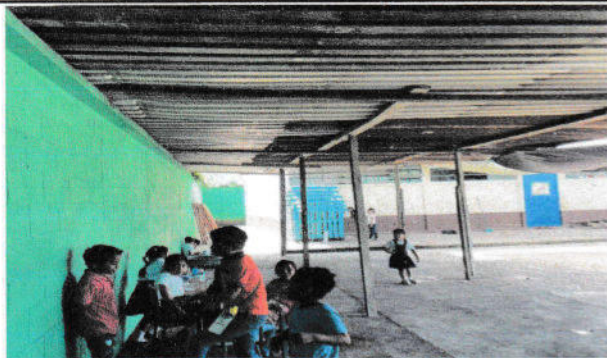
Foto 1: Sustitución de estructura de soporte madera, por metal
