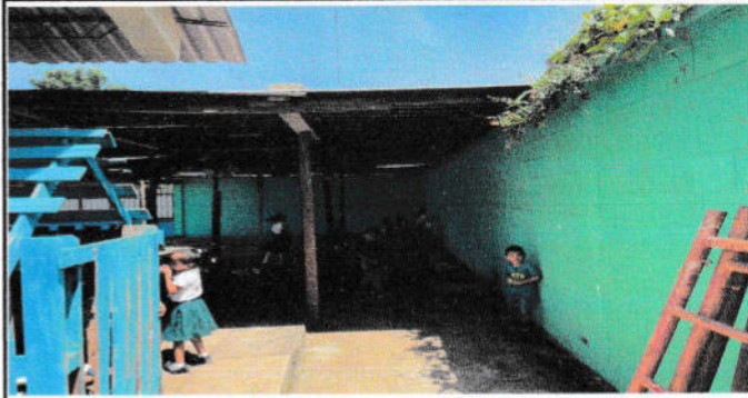
Foto 2: Sustitución de lámina, por lámina troquelada cal. 26
