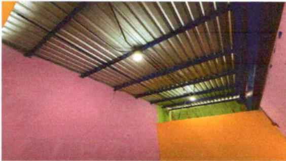
FOTO #1. Sustitución de techo de estructura metálica, 255 metros cuadrados
