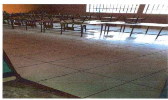
FOTO # 4. Sustitución piso en aulas de cemento por cerámico, 152 metros cuadrados
