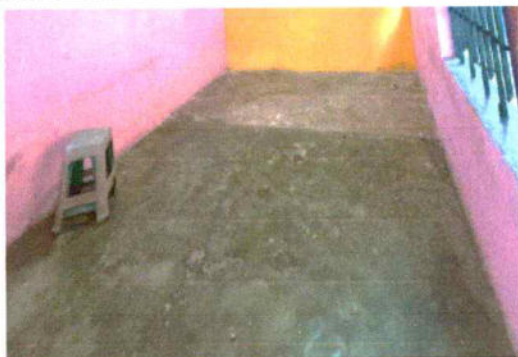
FOTO #3. Sustitución piso en aulas de cemento por cerámico, 152 metros cuadrados
