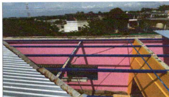
FOTO #2. Sustitución de techo de estructura metálica, 255 metros cuadrados
