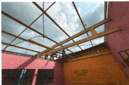
FOTO #1. Sustitución de techo de estructura metálica, 255 metros cuadrados
