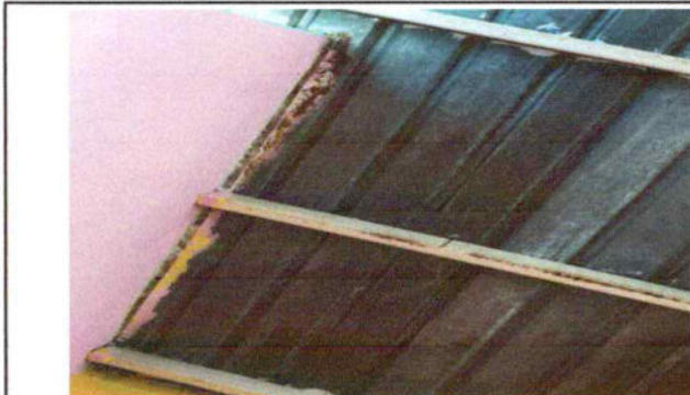
No.1 Sustitución de techo de estructura metálica, un total de 255 metros cuadrados
