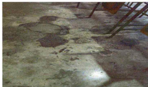
No.2 Sustitución piso en aulas de cemento por cerámico un total de 152 metros cuadrados
