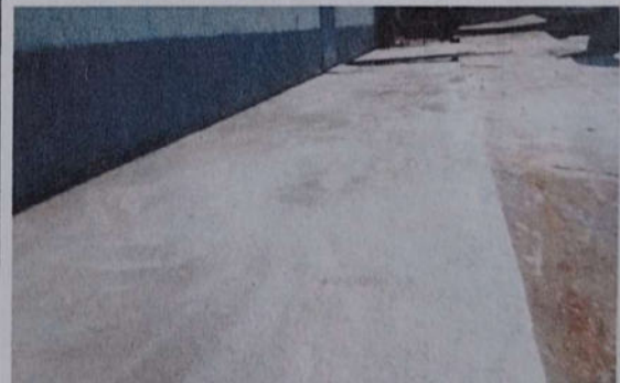
Foto # 4: REPARACIÓN Y SUSTITUCIÓN DE BANQUETA DE CONCRETO
