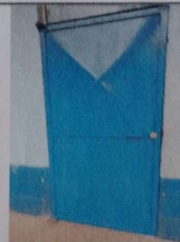
Foto # 6: SUSTITUCIÓN DE CHAPAS Y MANTENIMIENTO DE PUERTAS
