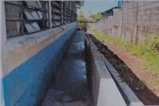
Foto # 1: REPARACIÓN Y SUSTITUCIÓN DE CUNETA DE CONCRETO
