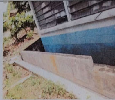
Foto # 2: REPARACIÓN DE MURO DE CONTENCIÓN
