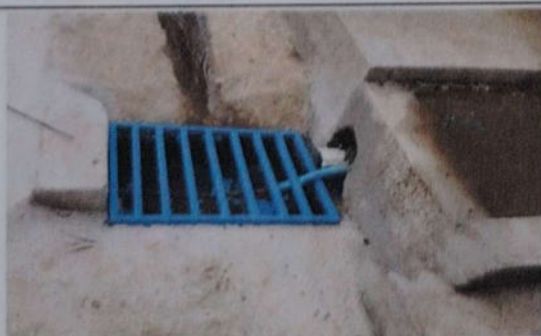
Foto # 5: SUSTITUCIÓN Y MANTENIMIENTO DE CAJA DE REGISTRO
