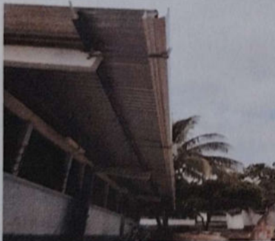
Foto # 3: SUSTITUCIÓN DE CANAL Y CARGADORES
