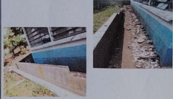
Foto # 2: REPARACIÓN DE MURO DE CONTENCIÓN
