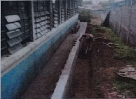
Foto # 1: REPARACIÓN Y SUSTITUCIÓN DE CUNETAS DE CONCRETO
