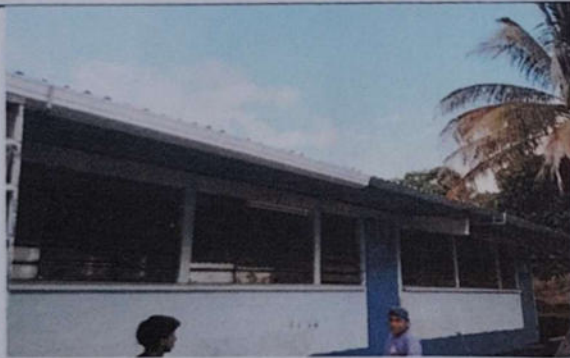
Foto # 3: SUSTITUCIÓN DE CANAL Y CARGADORES
