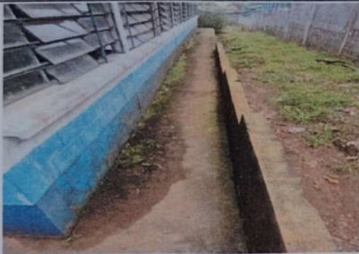
Foto # 1: REPARACIÓN Y SUSTITUCIÓN DE CUNETAS DE CONCRETO
