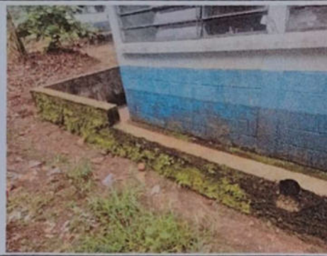
Foto # 2: REPARACIÓN DE MURO DE CONTENCIÓN
