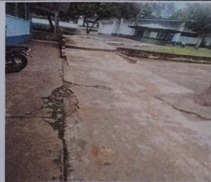
Foto # 4: REPARACIÓN Y SUSTITUCIÓN DE BANQUETA DE CONCRETO
