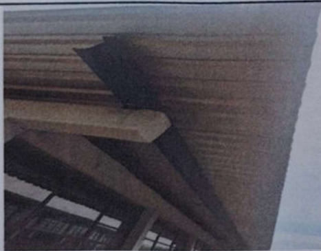
Foto # 3: SUSTITUCIÓN DE CANAL Y CARGADORES
