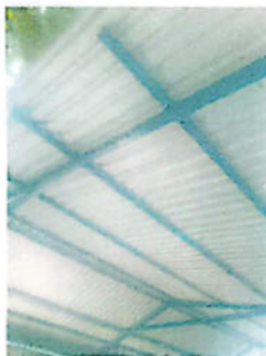
SUSTITUCIÓN DE LAMINA TROQUELADA POR LÁMINA TROQUELADA CALIBRE 26
