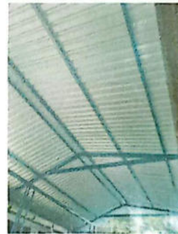
SUSTITUCION DE ESTRUCTURA DE METAL POR METAL
