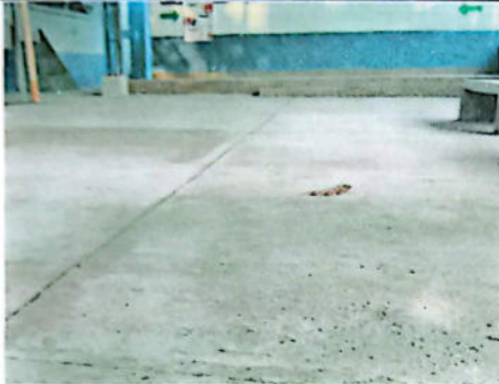
SUSTITUCIÓN DE TORTA DE CONCRETO POR TORTA DE CONCRETO
