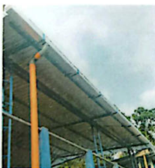
SUSTITUCIÓN DE CANAL DE METAL POR METAL
