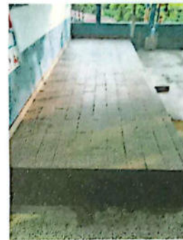
SUSTITUCIÓN DE PISO DE CONCRETO POR PISO CERÁMICO
