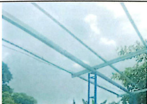
SUSTITUCIÓN DE CANAL DE METAL POR METAL
