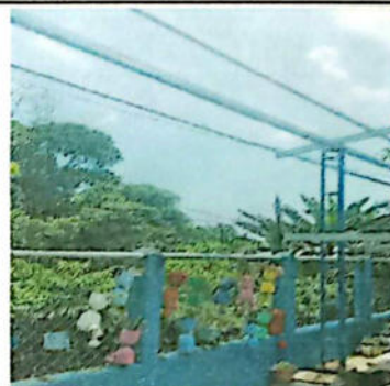
SUSTITUCIÓN DE ESTRUCTURA DE METAL POR METAL
