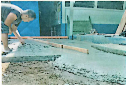
SUSTITUCION DE TORTA DE CONCRETO POR TORTA DE CONCRETO
