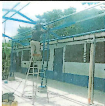
SUSTITUCIÓN DE LAMINA TROQUELADA POR LÁMINA TROQUELADA CALIBRE 26
