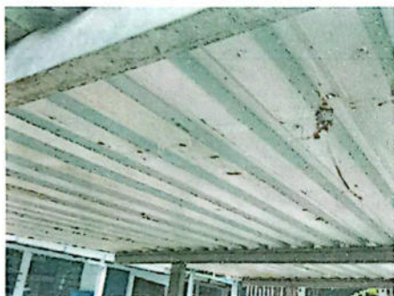
SUSTITUCIÓN DE LAMINA TROQUELADA POR LÁMINA TROQUELADA CALIBRE 26
