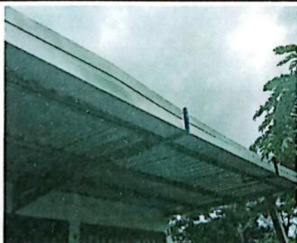
SUSTITUCIÓN DE CANAL DE METAL POR METAL
