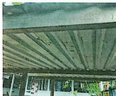
SUSTITUCION DE ESTRUCTURA DE METAL POR METAL
