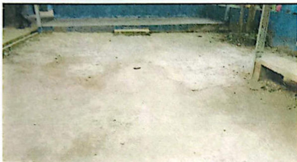
SUSTITUCIÓN DE TORTA DE CONCRETO POR TORTA DE CONCRETO
