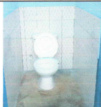
Foto 2: Sustitución de azulejo en sanitario
