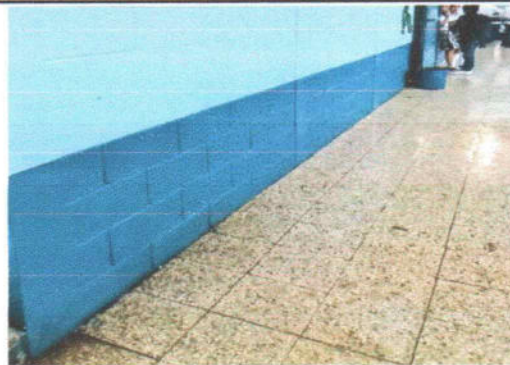
Foto 8: Suministro y aplicación Pintura exterior látex Azul Pantone 293 para zócalo 4 hiladas
