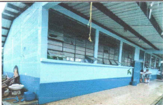
Foto 7: Suministro y aplicación pintura exterior látex celeste Pantone 293 para muros
