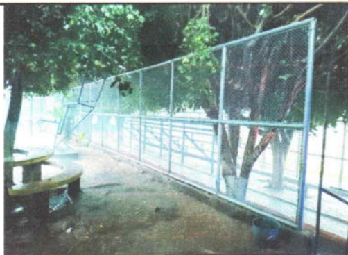
Foto 3: Reparación de tubo y malla galvanizada
