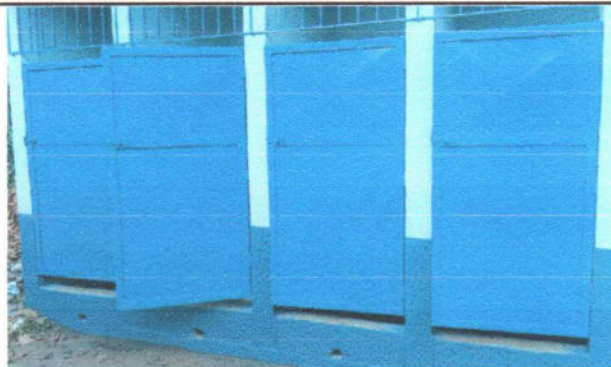
Foto 4: Mantenimiento a estructura (lijado, cambio de tubi, cepillado, sujeciones, aplicación de pintura)
