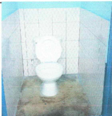
Foto 9: Sustitución inodoro elongado
