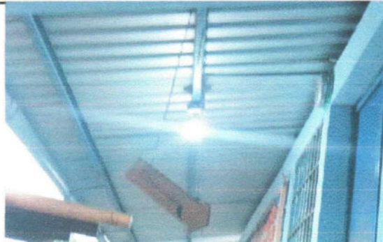
Foto 6: Sustitución de lámparas existentes con lámparas de BOMBILLO LED GLOBO 30W PARA PASILLOS 2400 lúmenes
