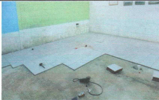
Foto 1: Sustrucción de piso de granito y torta por piso cerámico
