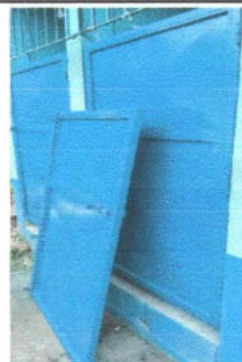
Foto 4: Mantenimiento a estructura (lijado, cambio de tubo, cepillado, sujeciones, aplicación de pintura)
