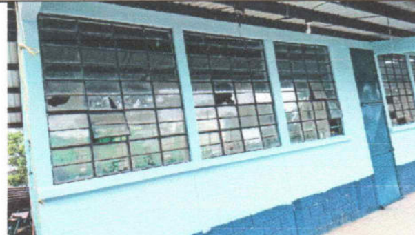
Foto 8: Suministro y aplicación Pintura exterior látex Azul Pantone 293 para zócalo 4 hiladas
