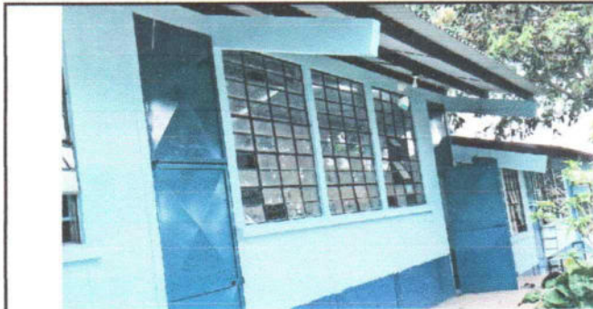
Foto 7: Suministro y aplicación Pintura exterior látex celeste Pantone 293 para muros
