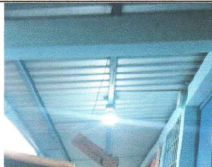
Foto 6: Sustrucción de lámparas existentes con lámparas BOMBILLO LED GLOBO 30W PARA PASILLOS 2400 Lúmenes
