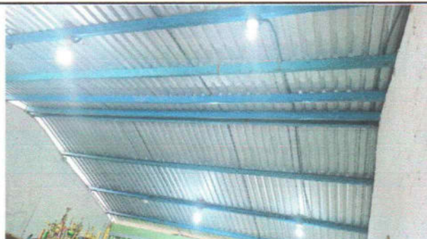
Foto 5: Reparación de cableado eléctrico
