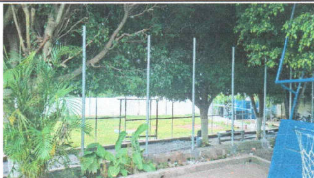
Foto 3: Reparación de tubo hg y malla galvanizada
